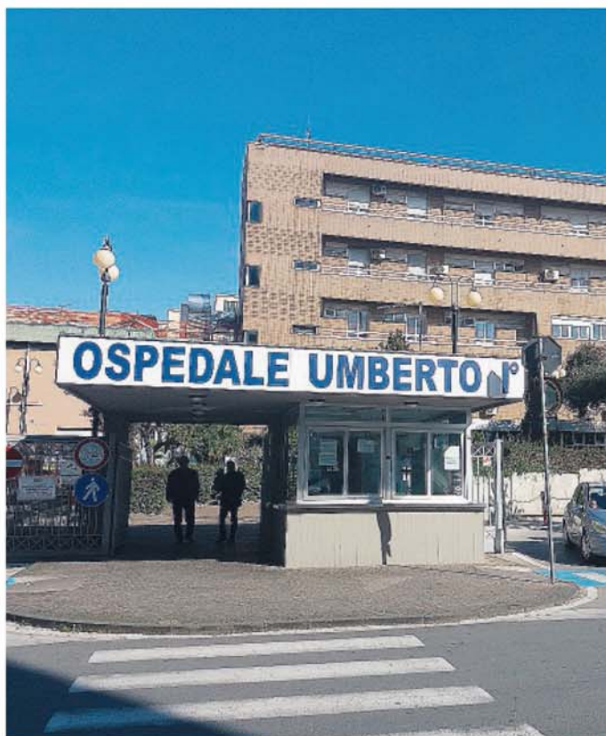
Sanità. L'ingresso del presidio ospedaliero di via Testaferrata
